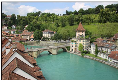
Bern. Pont Nydeggbrücke sur l'Aare
